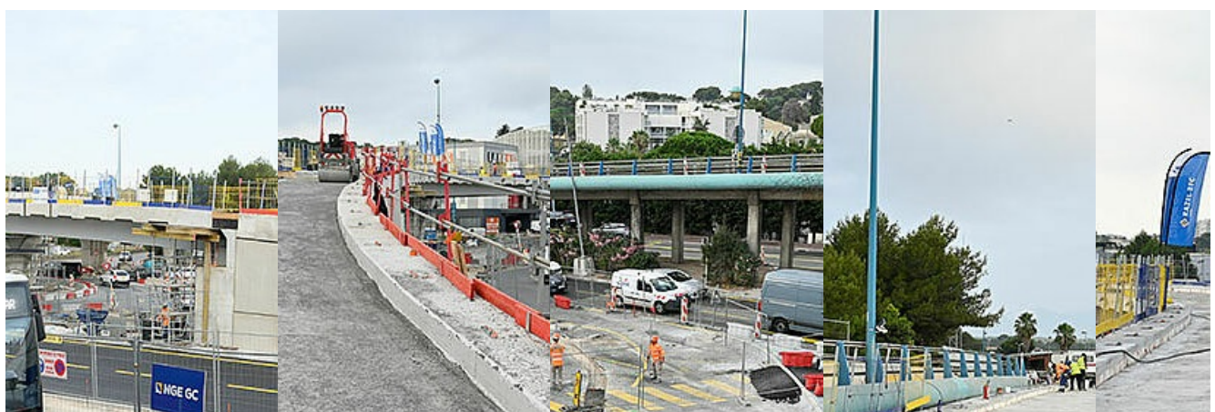
Photos en date du 12 juillet
