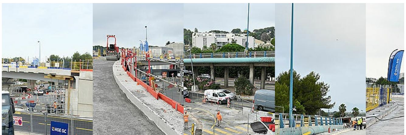
Photos en date du 12 juillet
