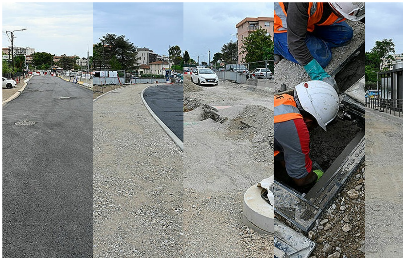
Photos en date du 3 juin
