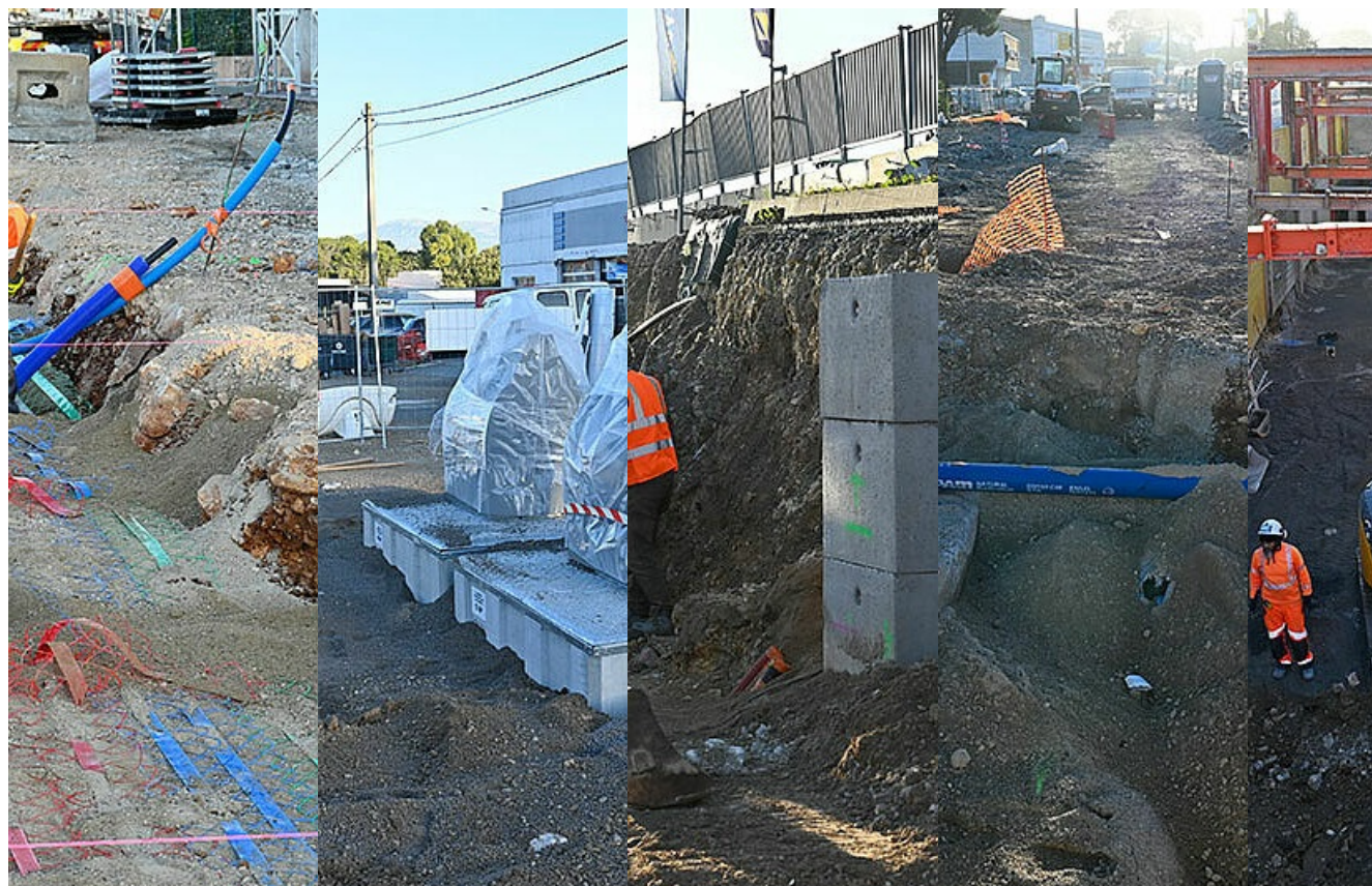
Photos en date du 17 novembre
